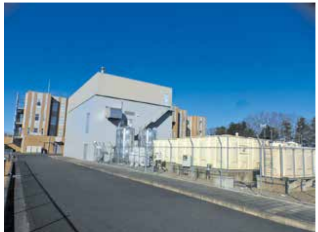
設備の核となるエネルギー棟
