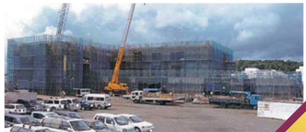
▲ 建設中の当院（平成17年9月7日撮影）
